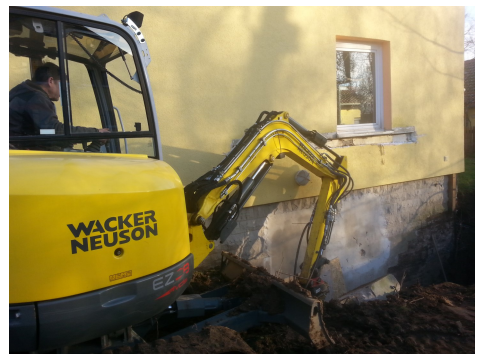
Interessant sind auch die Erdarbeiten ...
